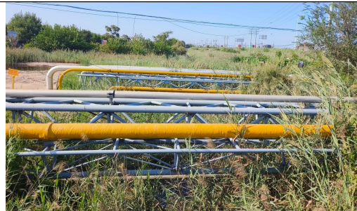
利旧已建桁架跨越津歧路西侧沟渠
