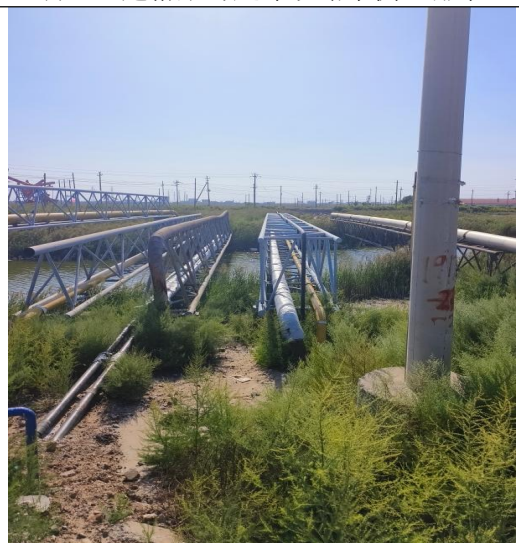
利旧已建桁架跨越板桥河
