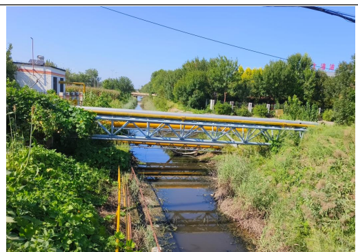
利旧已建桁架跨越光明大道东侧沟渠
