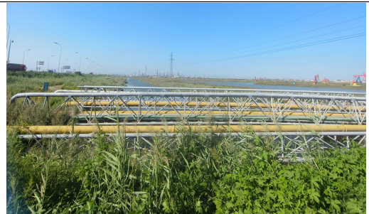
利旧已建桁架跨越津歧路东侧二排干
