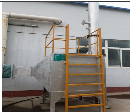
排气筒 P4 采样平台及采样口
