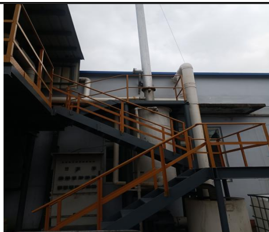
排气筒 P3 采样平台及采样口
