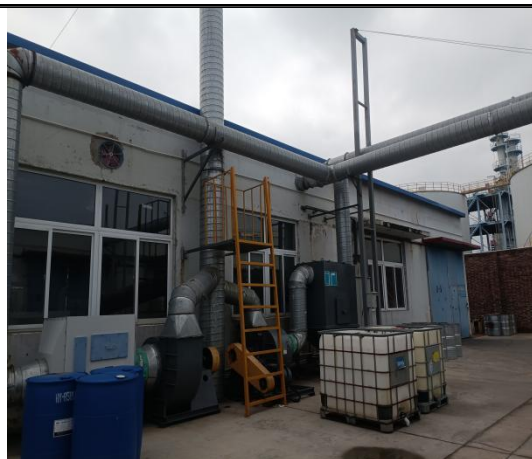
排气筒 P7 采样平台及采样口
