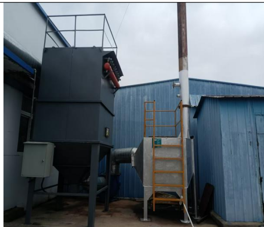
排气筒 P5 采样平台及采样口
