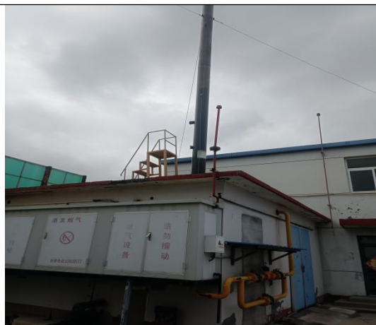
排气筒 P8 采样平台及采样口
