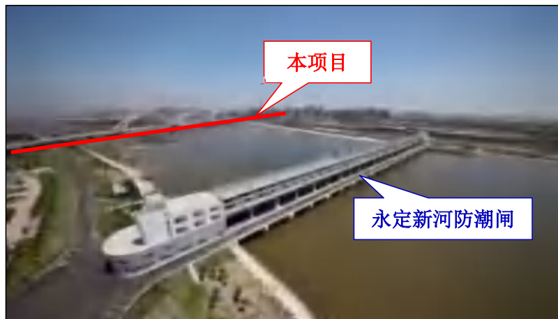
图5.1-4 永定新河防潮闸
