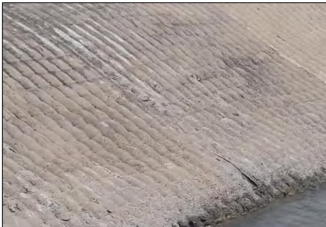
图 47 本项目永久占用陆域现状
