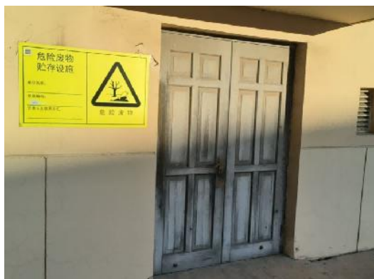
危废暂存间外部
