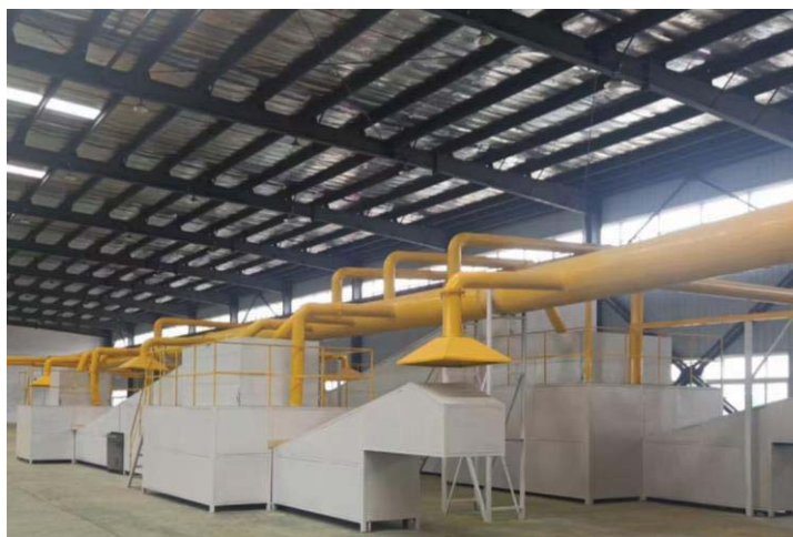
图 2.2-2 建设单位现有处置线设备密闭效果图
