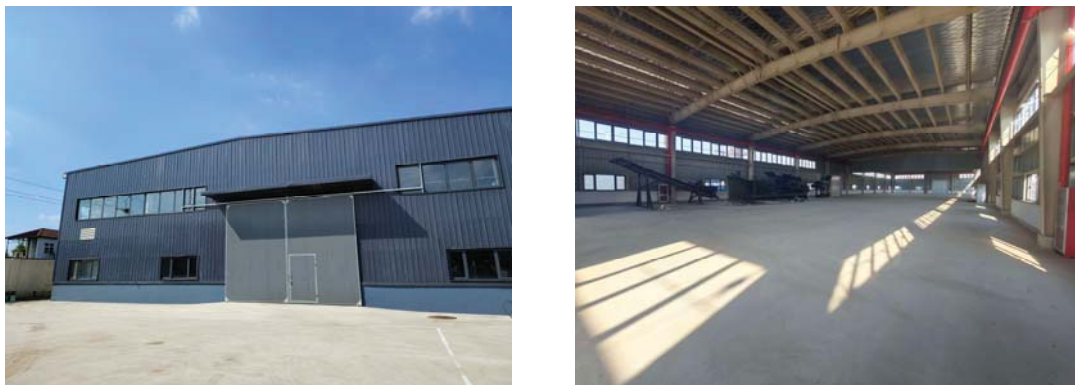
图3 本项目厂房照片
