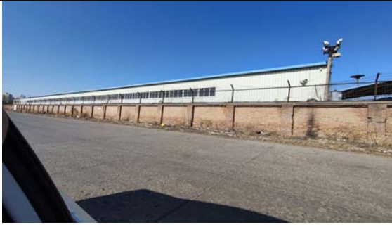
华港码头仓库
