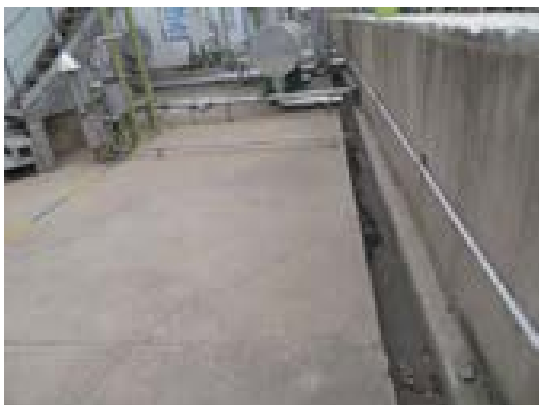
储罐围堰区内排水渠
