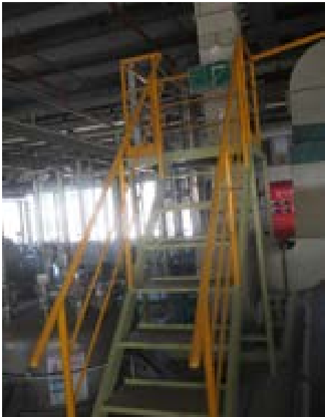
投料废气及中间品管实验室废气排气筒 P4
