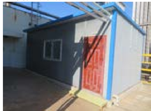
污水在线检测室
