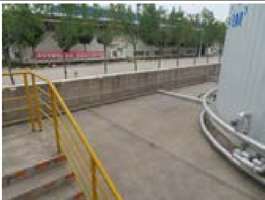
储罐区围堰
