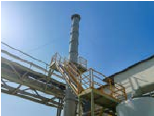
污水处理站废气排气筒 P9 采样平台及标识
