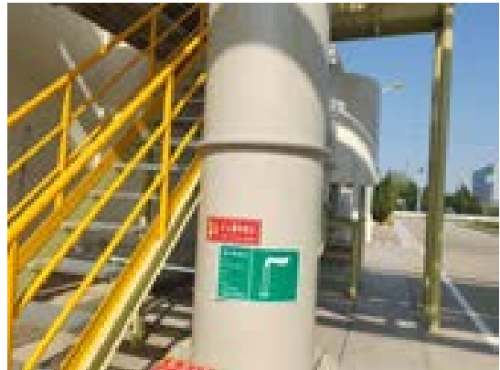
污水处理站废气排气筒 P9 采样平台及标识
