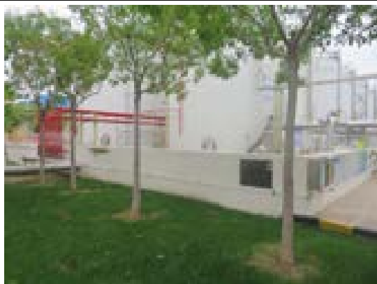
储罐区围堰
