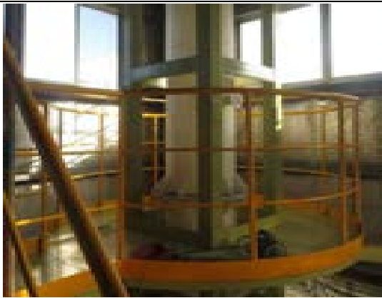
TO 设备排气筒 P7 采样平台及标识
