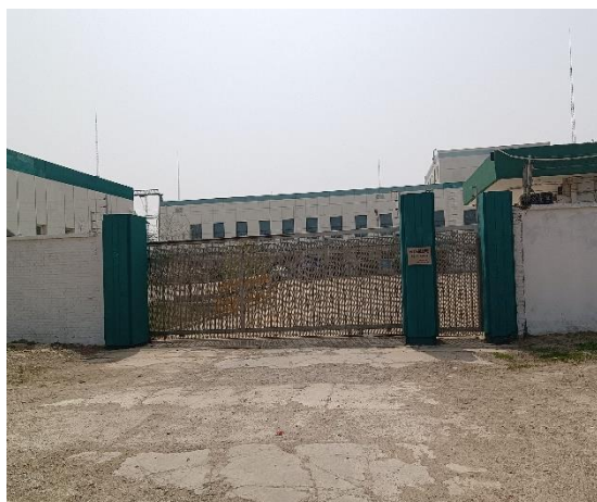
上古林 220kV 变电站北侧
