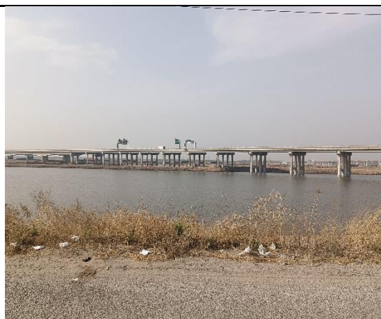
拟建 220kV 双回架空线路沿线
