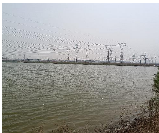
拟建 220/110kV 四回架空线路沿线
