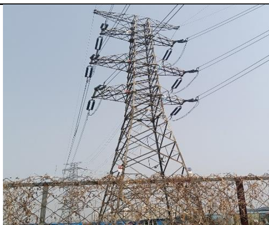
现状上海 2 线 1#塔
