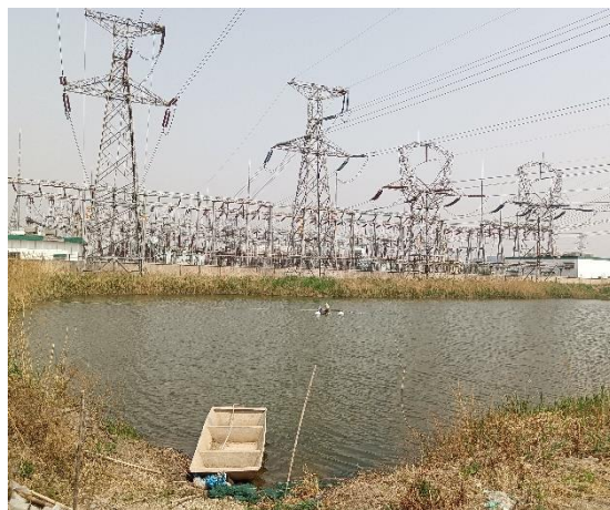
上古林 220kV 变电站南侧
