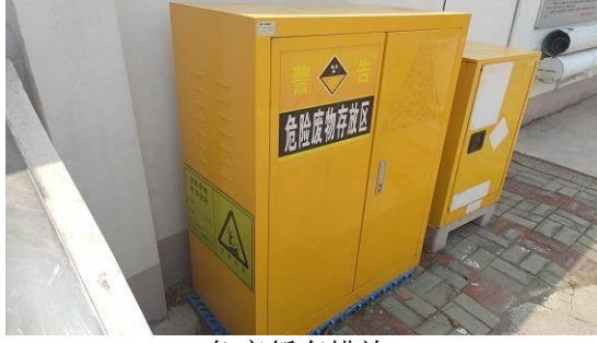
危废暂存措施
