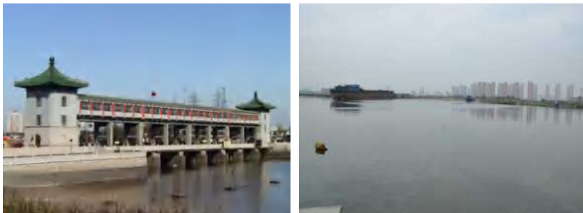
海河防潮闸及海河口现状
