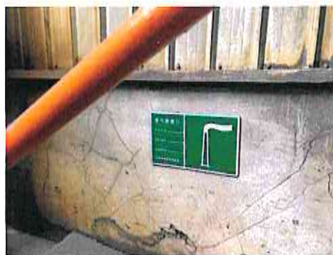
排气筒 FQ-089-14 标志牌
