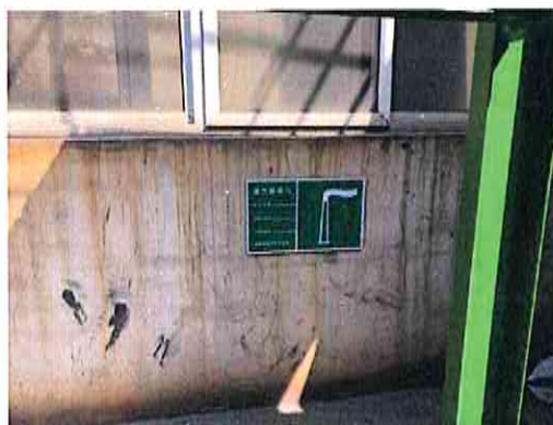
排气筒 FQ-089-16 标志牌
