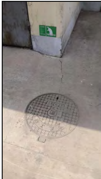
图 2-3 天津中油渤星工程科技有限公司现有污水总排口规范化照片
