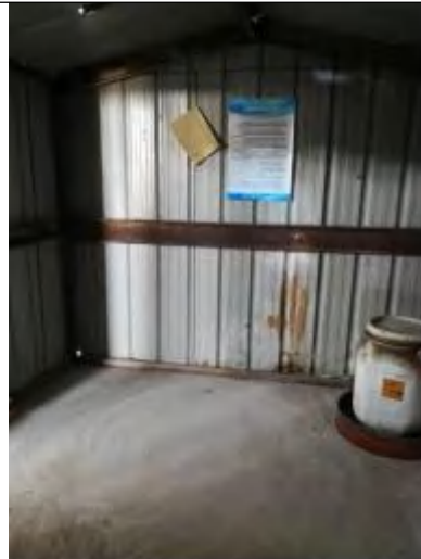
危险废物贮存场所外部
