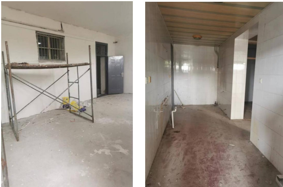
图 2.9-2 本项目新建锅炉房现状图
