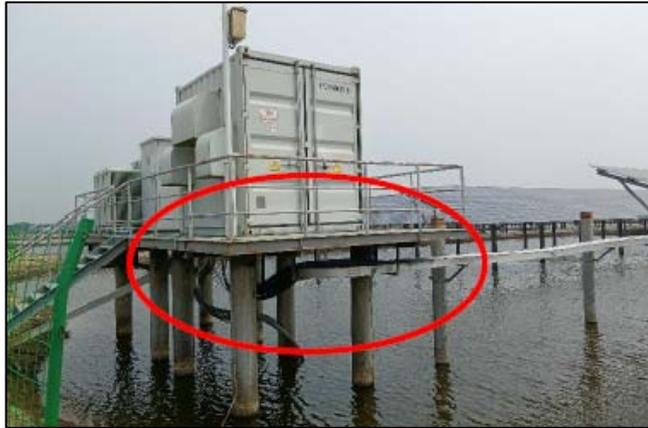
图 2-2 集中式逆变器钢平台布置示意图
