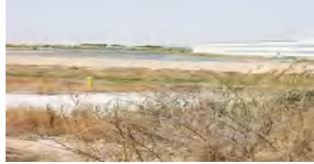
板桥河毛石护坡
