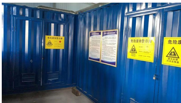
危险废物暂存间
