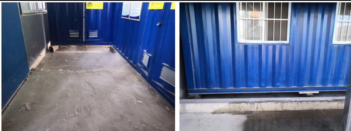
图 4.1-1 危险废物暂存间
