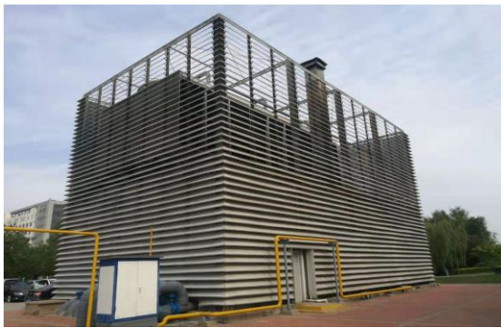
空调系统现有机房
