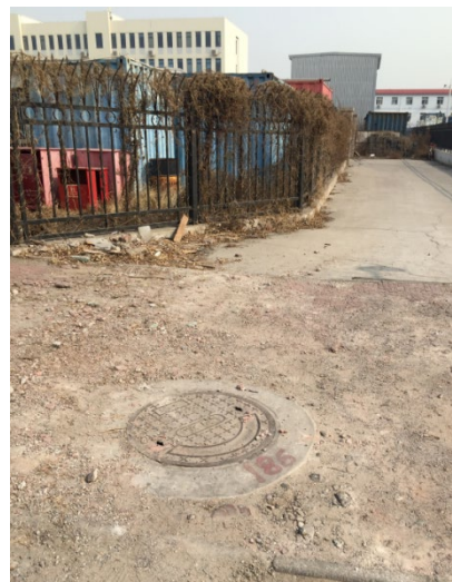
图 4 消防车间现有污水排放口（2 号，未启用）
